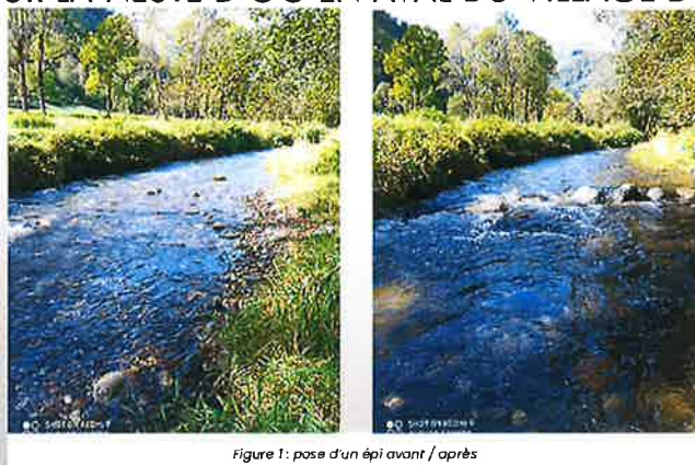
Figure 1: pose d'un épi avant / après
