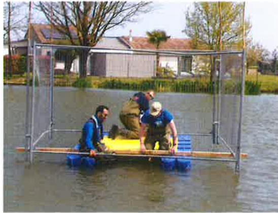
Mise en place au lac de Picayne Cazères
