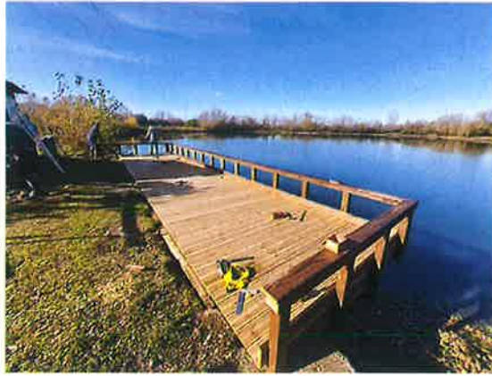
RÉNOVATION PONTON LAMARTINE
