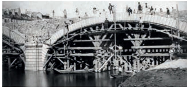
Construction du « pont neuf » à Mazères-sur-L'Hers. Demandée par la commune en 1852, l'étude ne fut lancée qu'en 1876-1877, après qu'une crue ait dévasté l'ancien pont en 1875. Mis en service au début de l'année 1882, il est toujours utilisé aujourd'hui.
