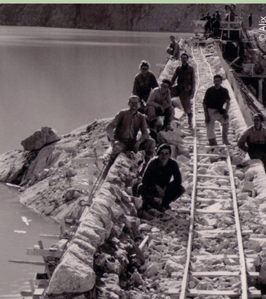
Le barrage du Portillon en construction. Pour édifier les barrages, on fit appel à de la main d'œuvre étrangère, espagnole ou italienne, parfois indochinoise
