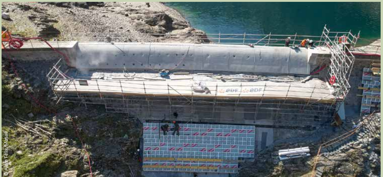
Coffrage et bétonnage du parement aval. Septembre 2020
