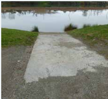
La rampe de Rieux avant les travaux
