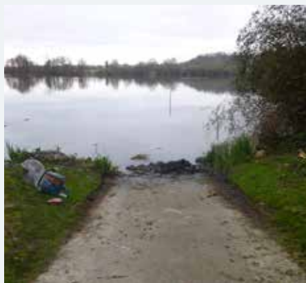
La rampe de Salles avant les travaux
