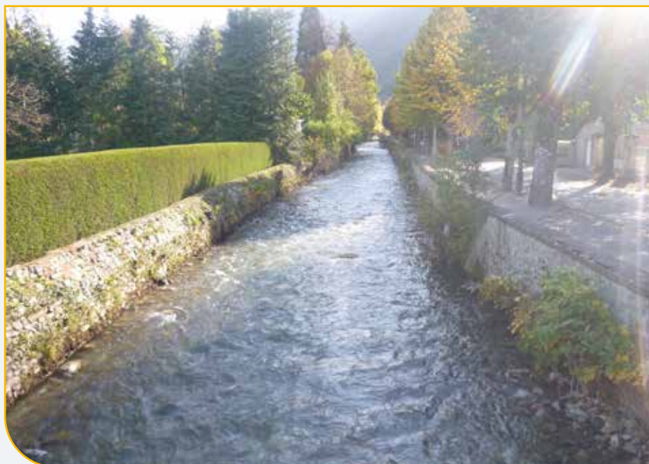
Octobre 2013, malgré la crue de juin, un profil rectifié engendre une uniformisation des écoulements, les blocs parsemés au milieu du lit n'offrent aucune plus-value sur les effectifs et les biomasses.
