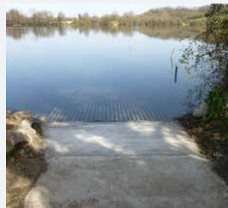
La nouvelle rampe de Salles après les travaux
