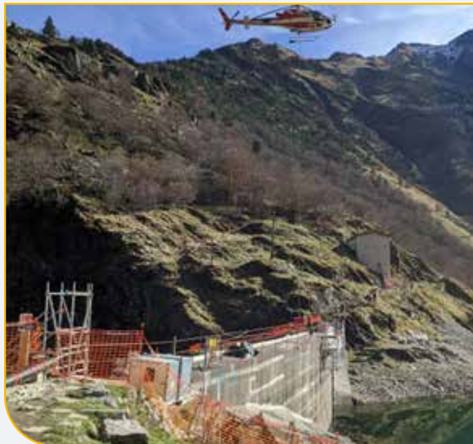
Héliportage de béton et de matériel
