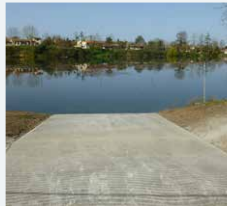
La nouvelle rampe de Rieux après les travaux
