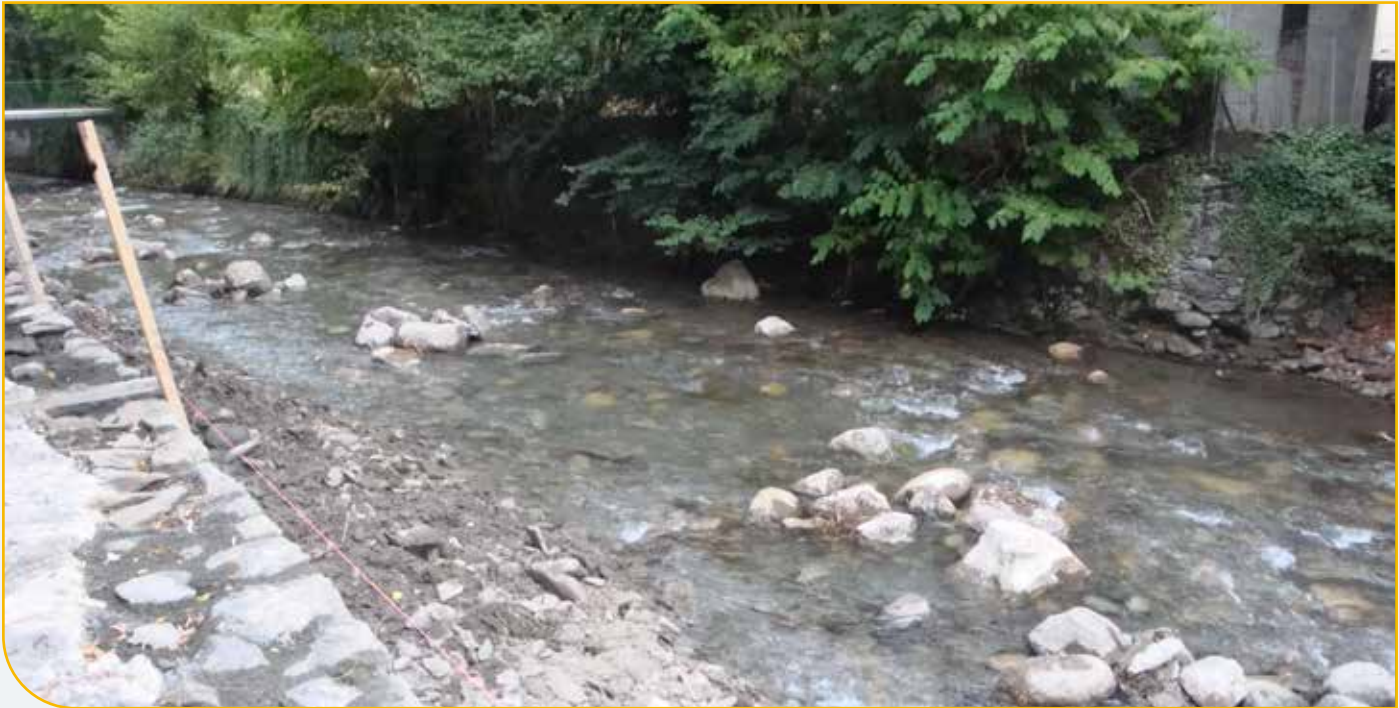
Curage de la Pique en 2016, les mesures compensatoires prévoient la remise en place des plus gros blocs. La diversification d'écoulements permet la formation de zones de frayères et les abris piscicoles en blocs une augmentation des effectifs de références du secteur mesurés sur 10 ans de suivi.
