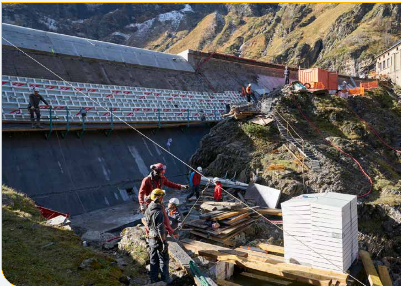
Coffrage et bétonnage du parement aval
