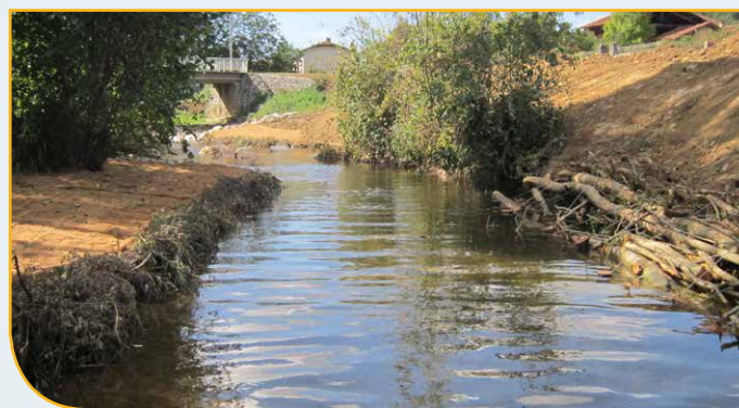
Risberme avec fascine de saules à gauche, fixation d'embâcles à droite
